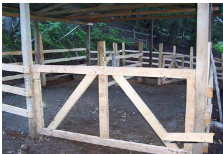
Fotografía 5 Corral construido de madera, lamina y cemento
