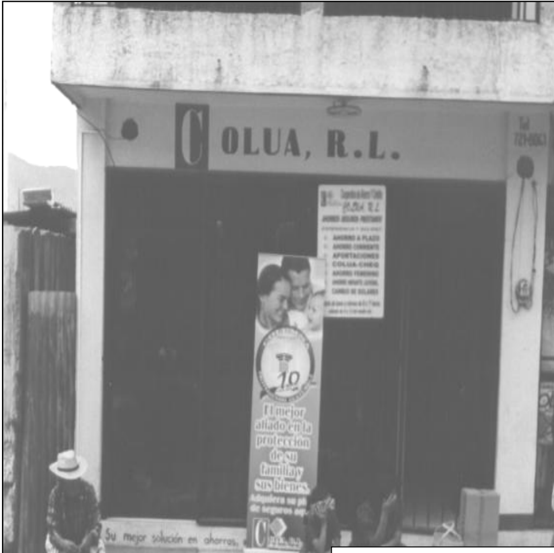
Primer nivel del edificio alquilado para oficina de atención a los asociados.
