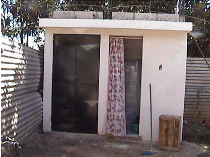
4. Módulos de sanitarios orientados inadecuadamente y sin ventilación natural.
