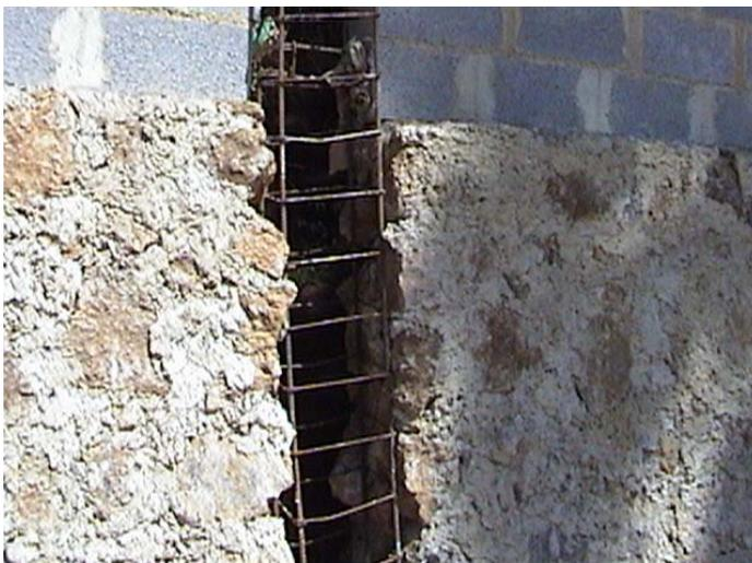
3. Estructuras de concreto reforzado débiles y con procesos constructivos inadecuados.
