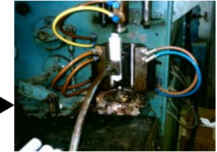
Brazo saca tubo INSPECCIÓN
