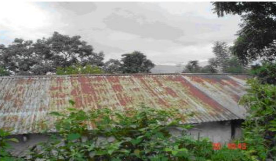
Foto 12: El tipo de casa es de adobe y techos de lámina galvanizada en general
