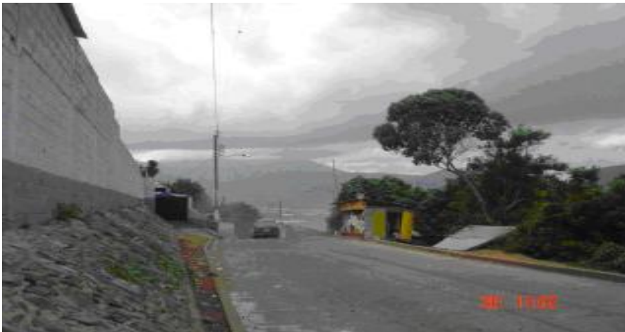
Foto 14: Carreteras de concreto, doble carril y en buen estado
