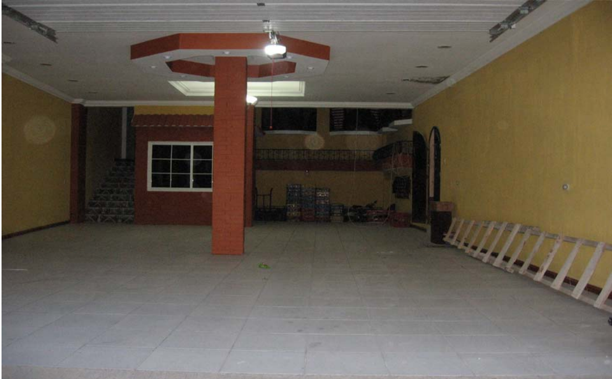
Fotografía 2 Área de Carga y Descarga de la Tienda Central, en Remodelación
