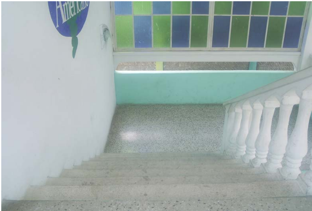
Imagen 13 Gradas Edificio Principal
