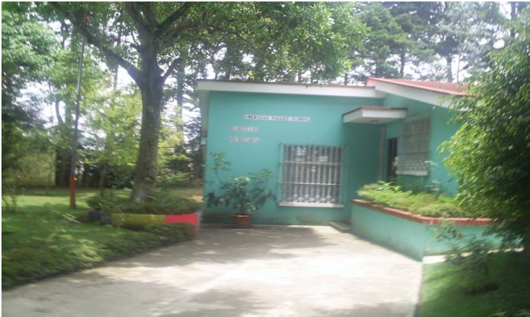
Imagen 4 Edificio de Oficinas Administrativas
