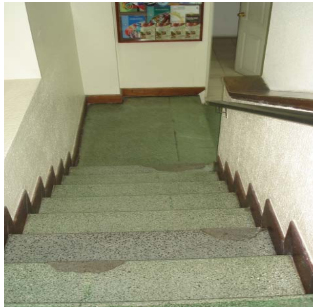
Fotografía 3 Gradas lado izquierdo del edificio
