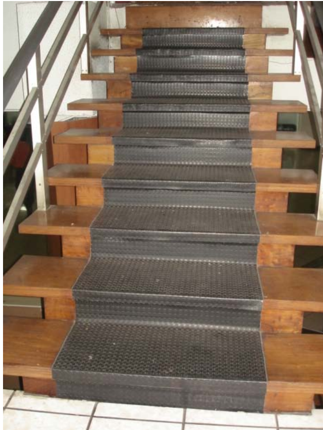
Gradas lado derecho del edificio
