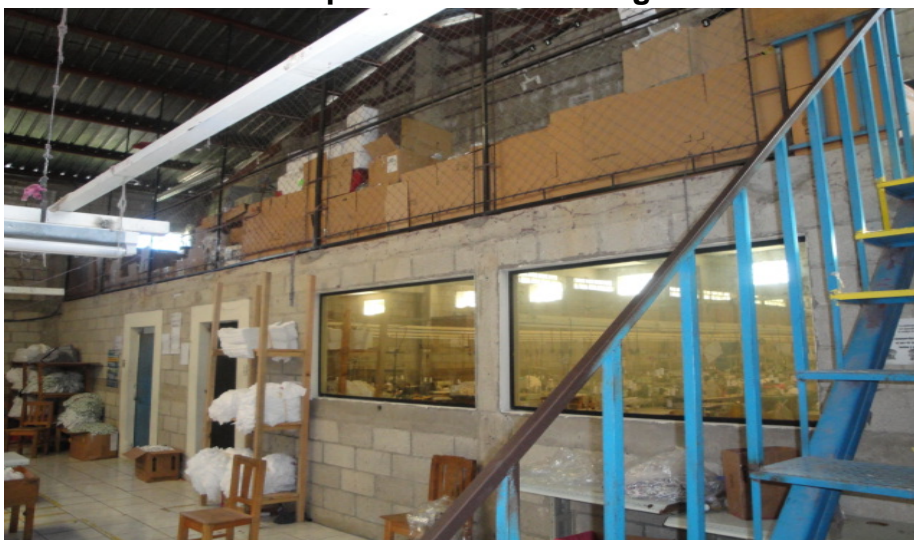
Fotografía 5 Departamento de bodega
