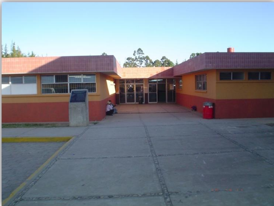
Vista frontal de la planta principal del Hospital Nacional “Santa Elena”, Santa Cruz del Quiché, mostrando el acceso a las instalaciones del mismo.
