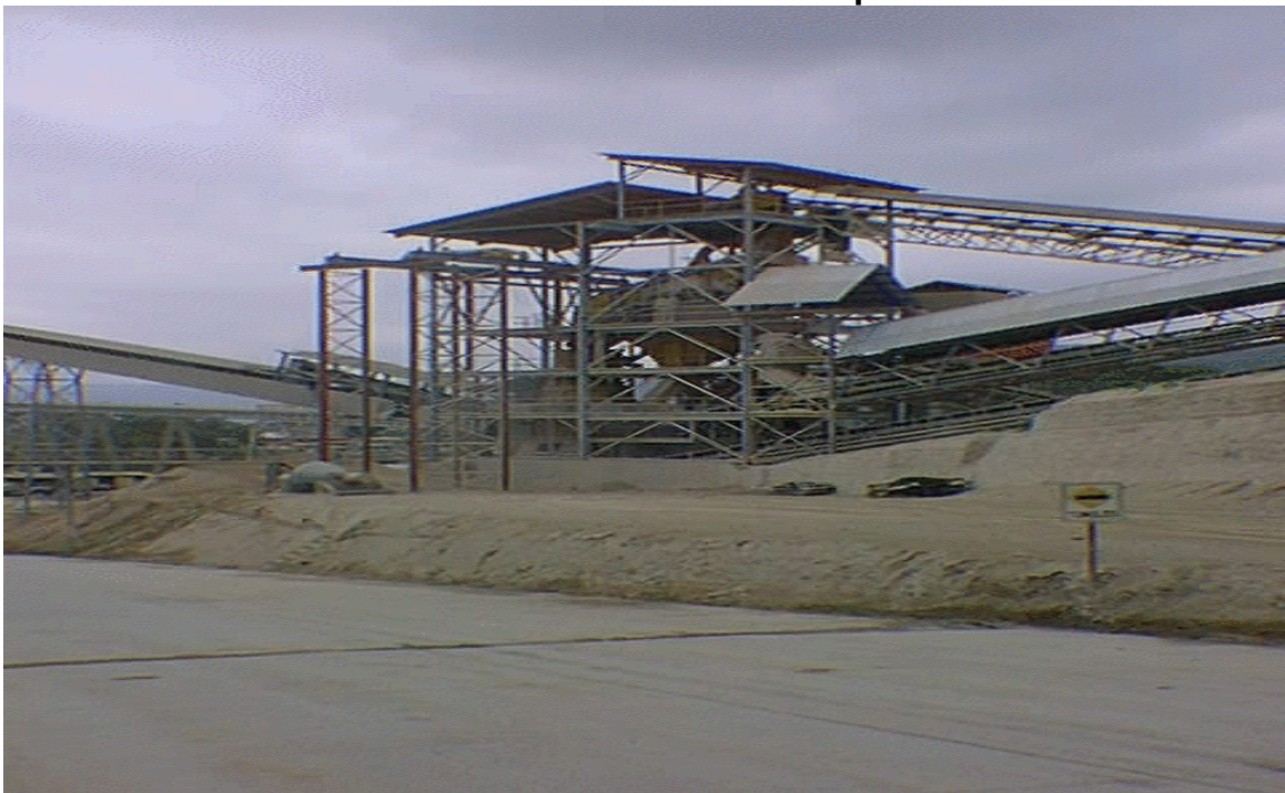
Imagen 2 Paso 2: Trituración de materia prima
