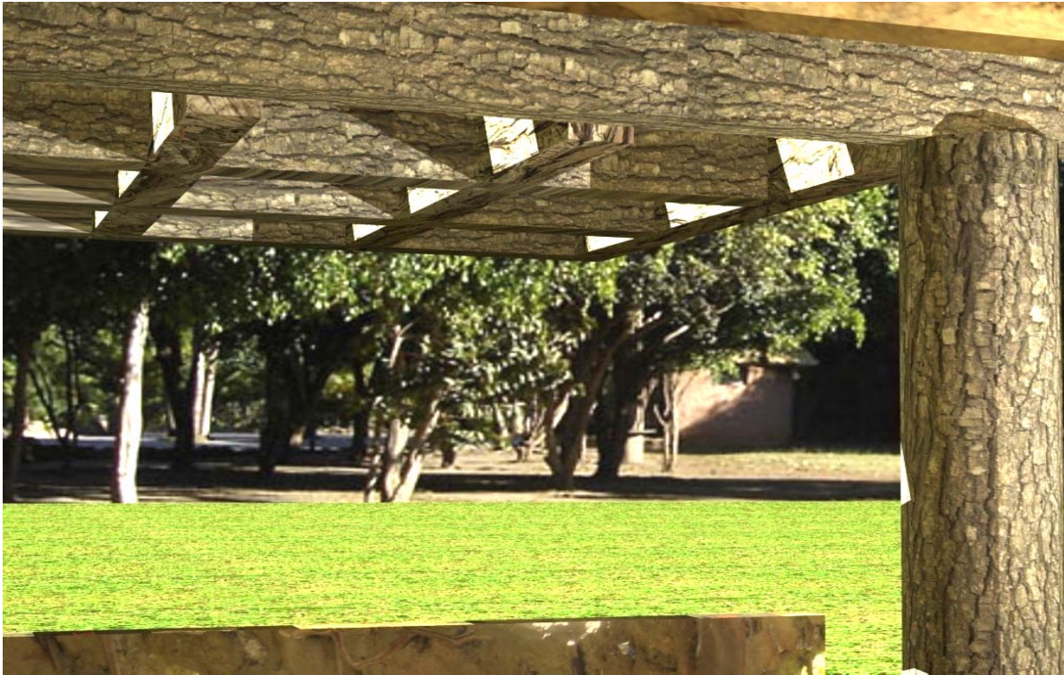
Vista desde interior
