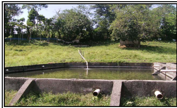
Foto No. 1 Piscícola construida de cemento su tecnología es sofisticada.
