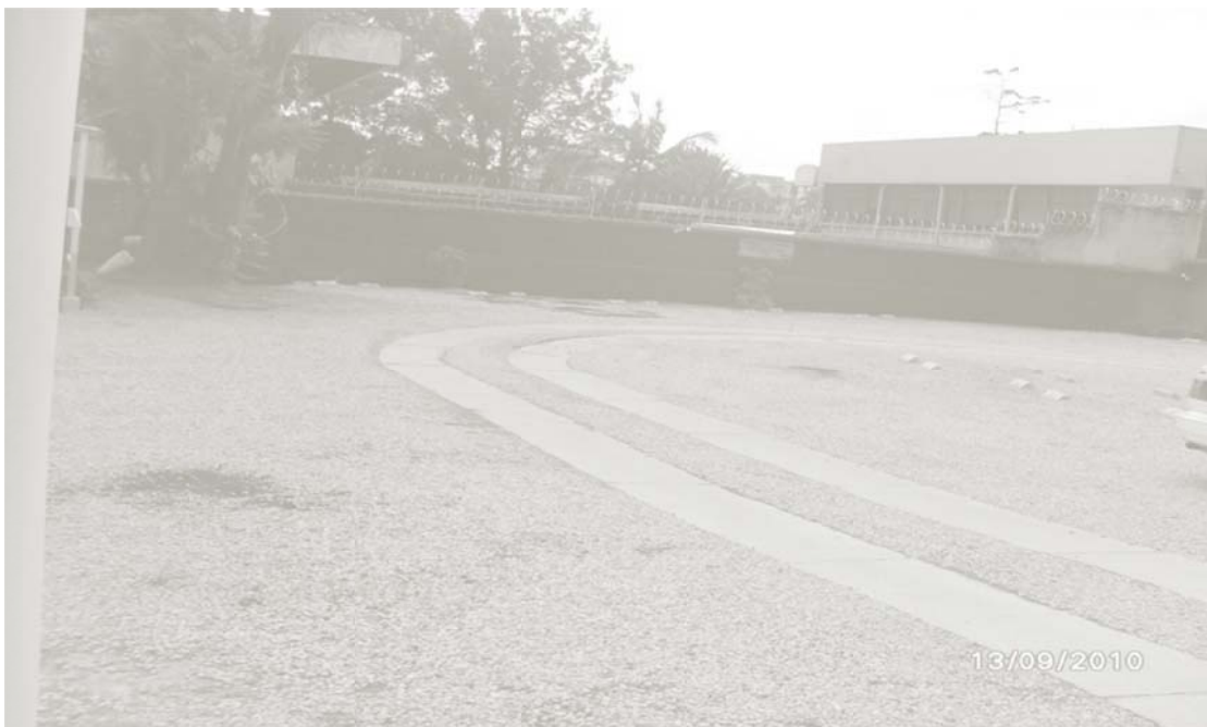
Área de parqueo (se sugiere su remodelación, debido a que es un espacio muy incómodo para el tránsito de los clientes y estacionamiento de vehículos).
