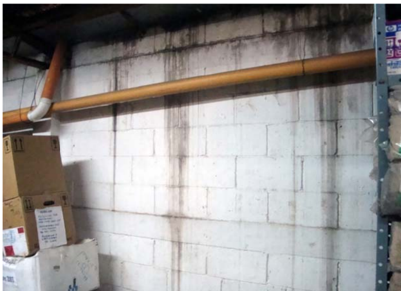
Imagen 3 Tubos de agua colocados en el 2do. Nivel
