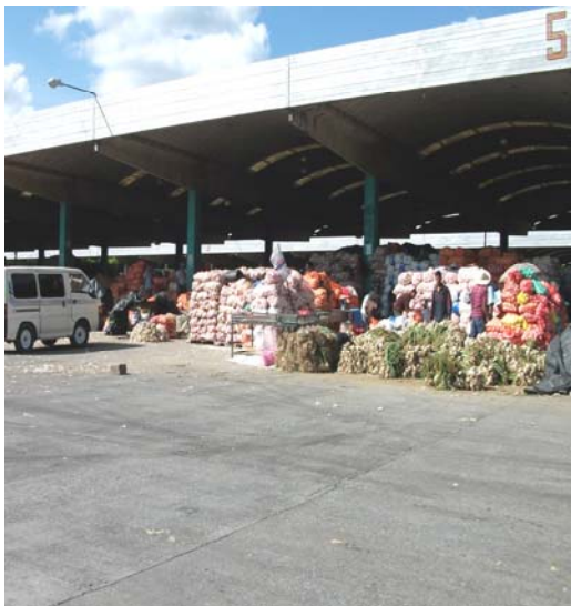
Imagen 56 Piso de concreto
