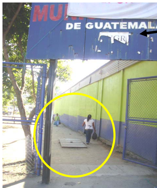
Imagen 18 Puerta de ingreso peatonal, sin letrero
