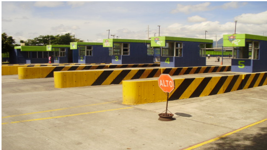
Imagen 11 Garitas en la entrada vehicular
