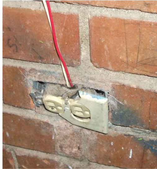
Imagen 36 Tomacorrientes deteriorado
