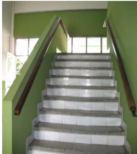
Imagen 63 Gradas y pasamanos, primer edificio administrativo
