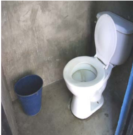
Imagen 52 Sanitario área mantenimiento
