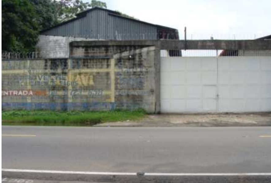
Fuente: imagen captada en trabajo de campo, enero 2011.
