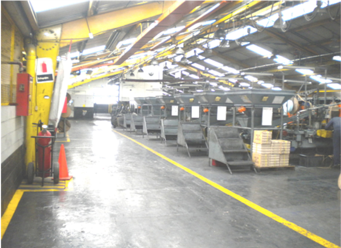
Fotografía 5 Panorámica del departamento de máquinas básicas Energía Total, S.A.
