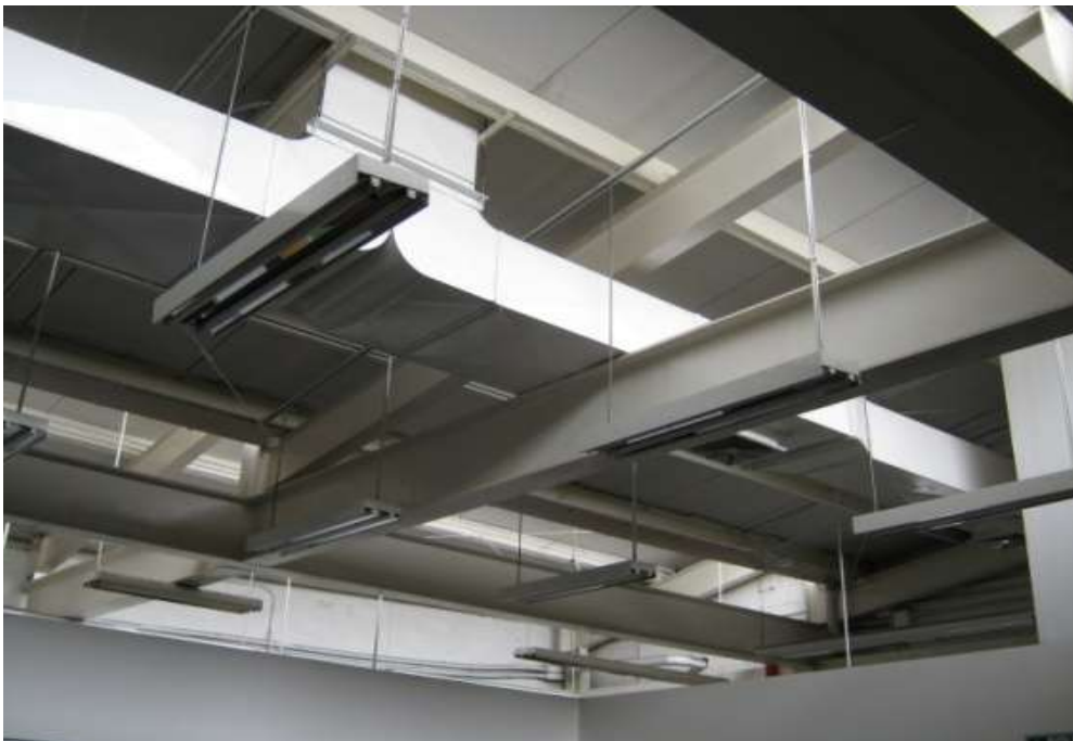
Fotografía 1 Techo del área de cubículos
