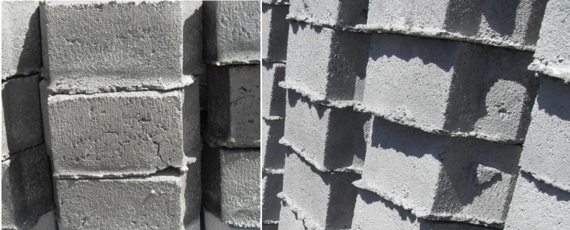
Efectos de producir con moldes en mal estado
