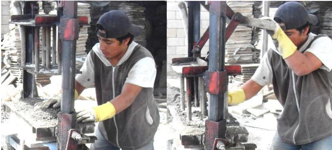
Proceso de vibrocompactación de la mezcla para obtener el adoquín
