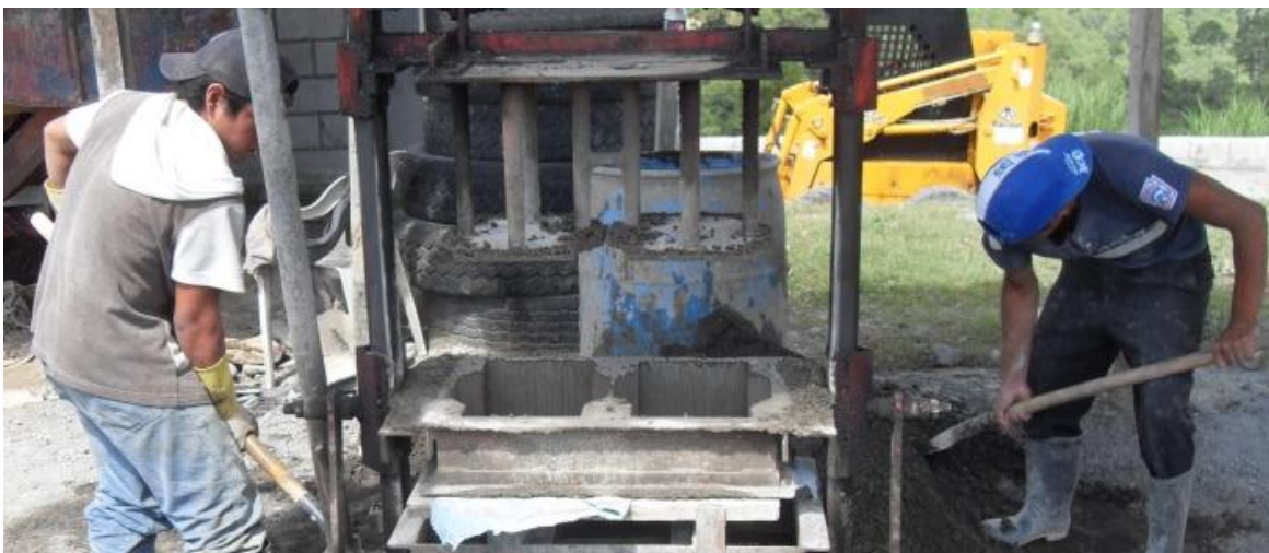
Vertido de la mezcla en los moldes de la vibrocompactadora
