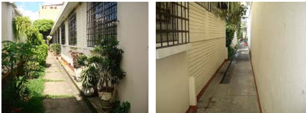
Pasillo izquierdo primer nivel y pasillo derecho primer nivel
