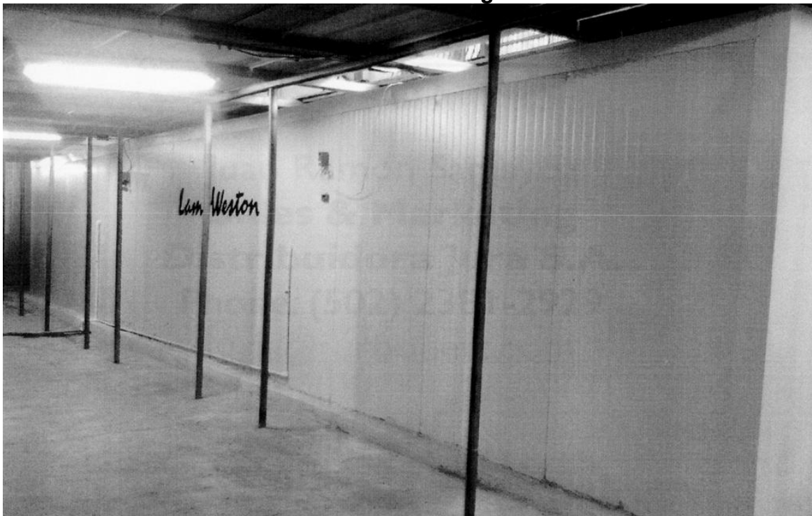
Imagen 11 Exterior de bodega
