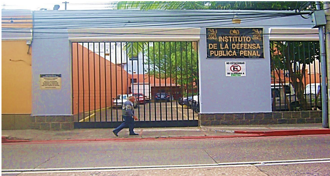
Imagen 50 Salida del edificio por la 8ª Avenida de la zona 1 Guatemala
