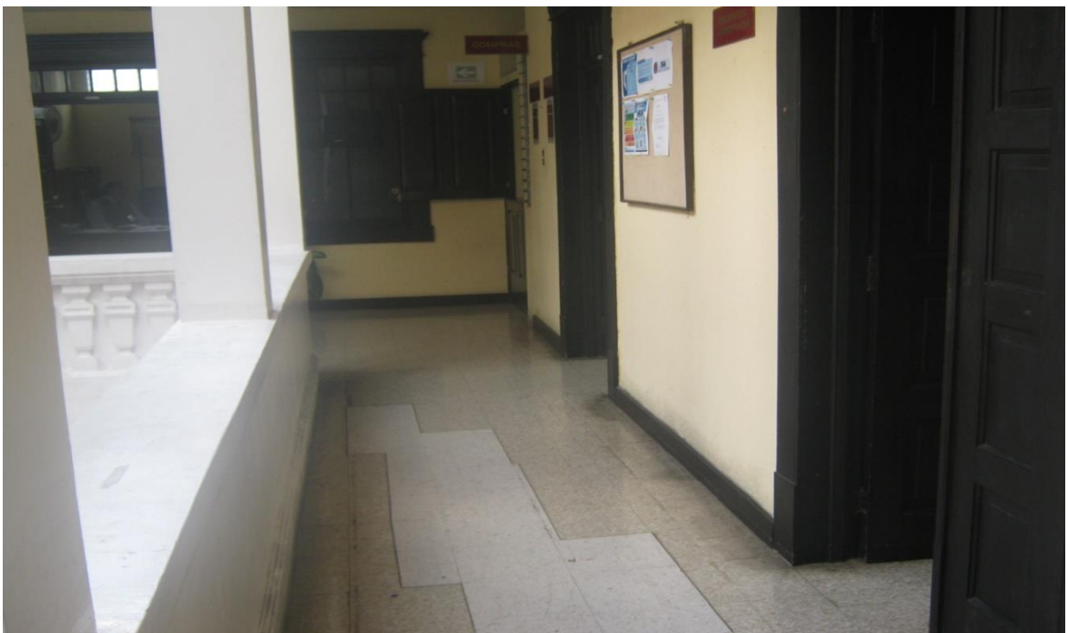
Imagen 30 Condiciones de las puertas
