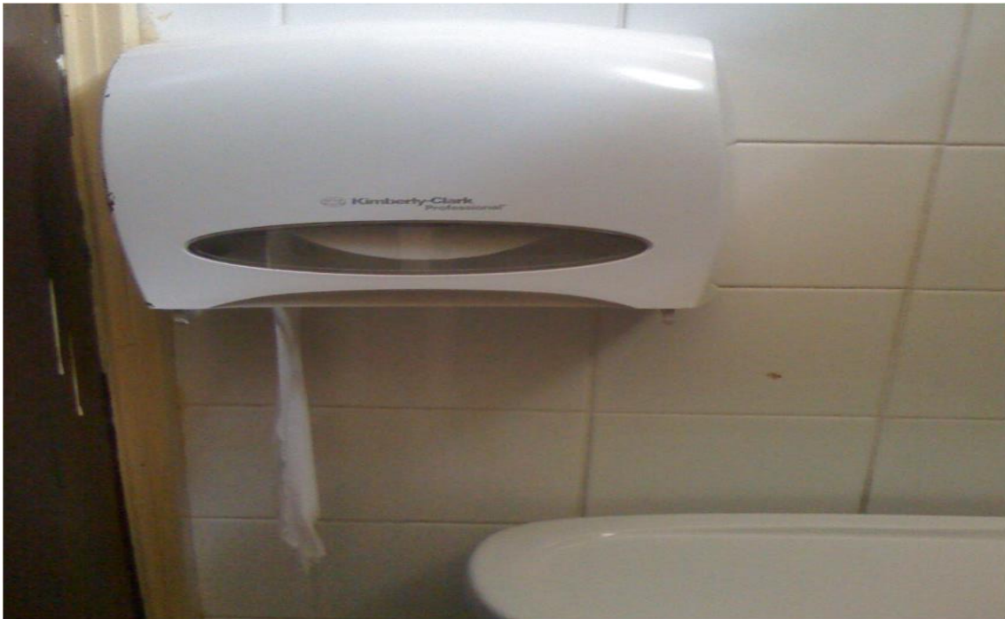
Imagen 12 Condiciones de los sanitarios
