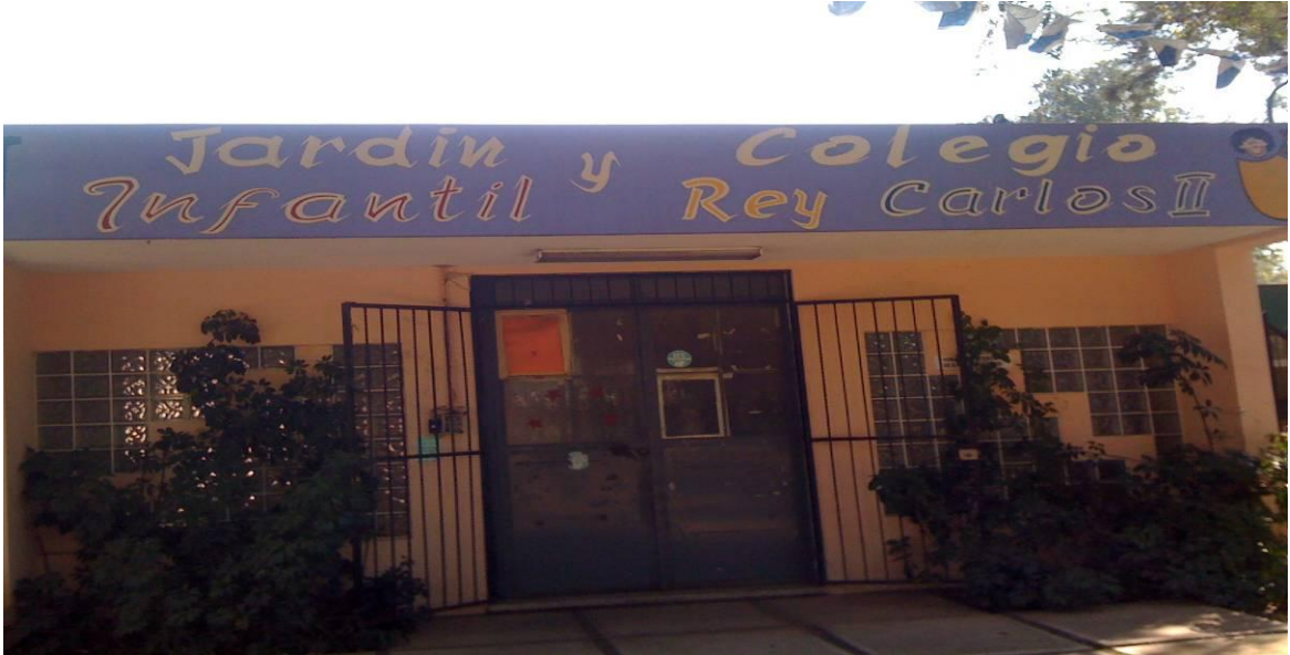
Figura 7 Vista de la entrada principal de las instalaciones del Jardín Infantil
