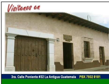
9. 8 segundos VOZ EN OFF: 3ra. Calle Poniente #32 a 50 metros de Calzada Santa Lucía.
