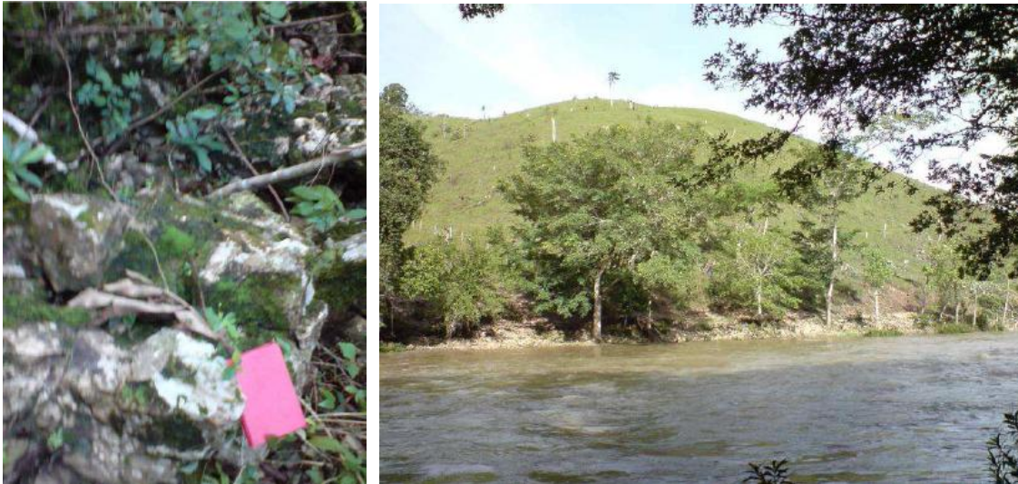
Figura 34. Proyecto hidroeléctrico El Camalote. Fotografías a) y b) Estribos derecho e izquierdo del valle en el sitio de presa
