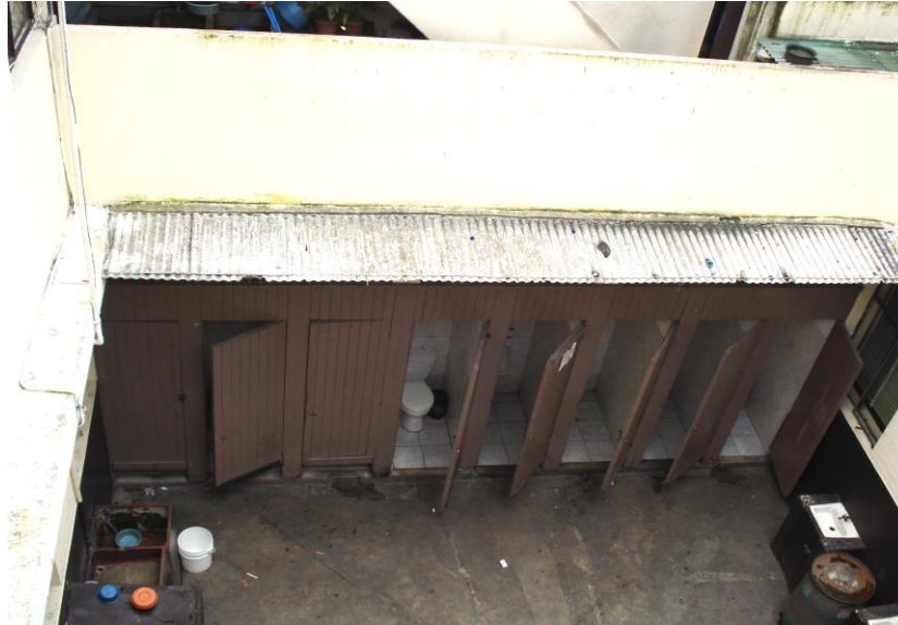
Imagen 20 Servicios sanitarios Primaria
