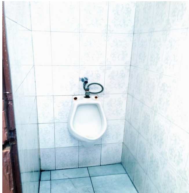
Imagen 21 Servicios sanitarios Primaria
