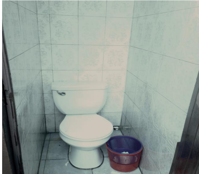
Imagen 24 Servicios sanitarios Área de secundaria
