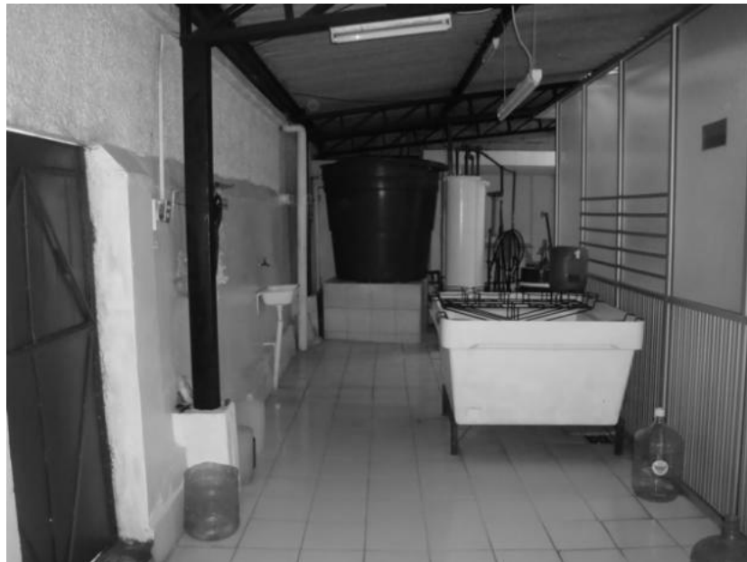
Imagen 14 Pasillo que conecta todas las áreas de la purificadora
