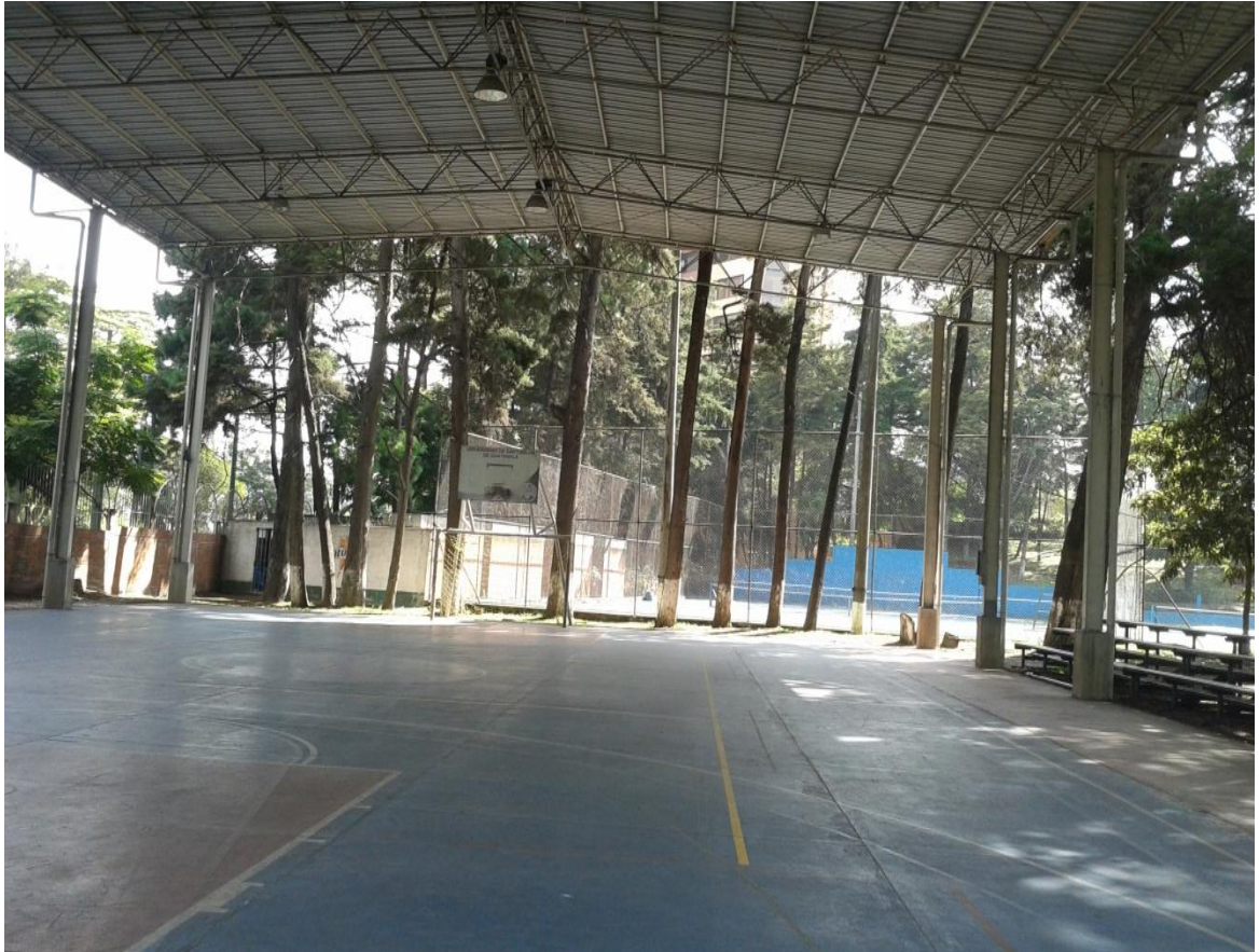
Figura 7 Polideportivo techado del Club Deportivo Los Arcos
