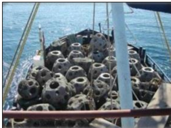
Figura 11. Utilización de barcasas para el hundimiento de las estructuras tipo reef ball . Fuente: DIPESCA, 2012.
