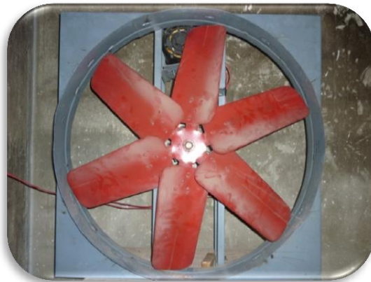
Imagen 17 Ventilador axial
