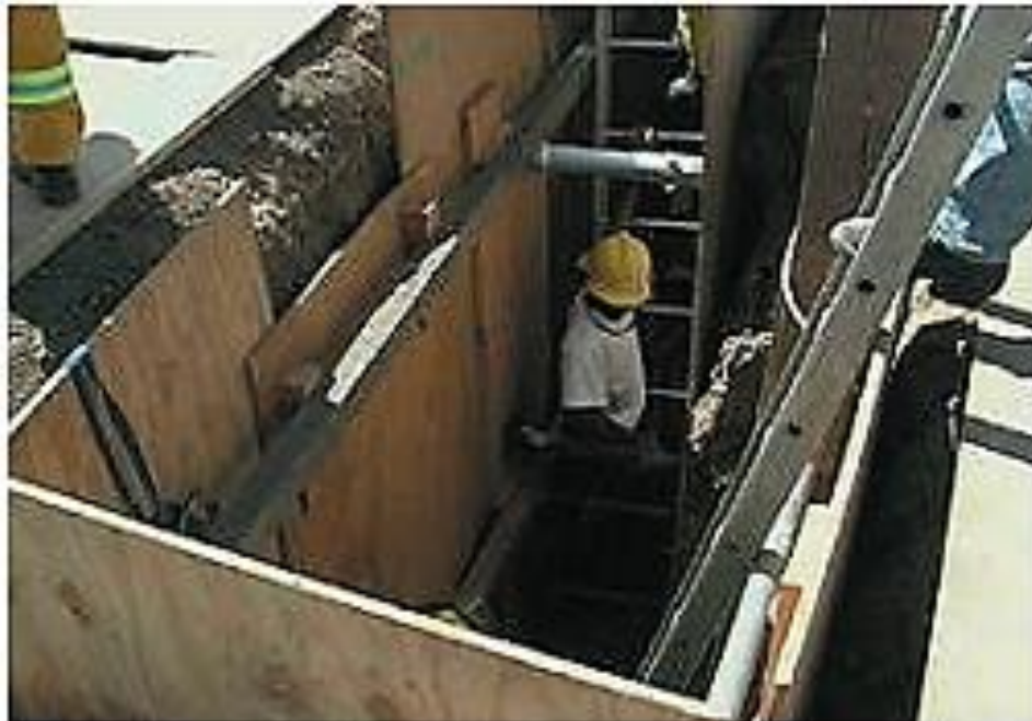
Imagen 37 Cajón de zanjas
