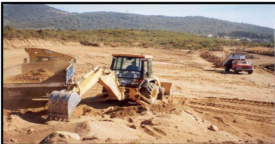
Figura 6 Servicio de nivelación de tierras
