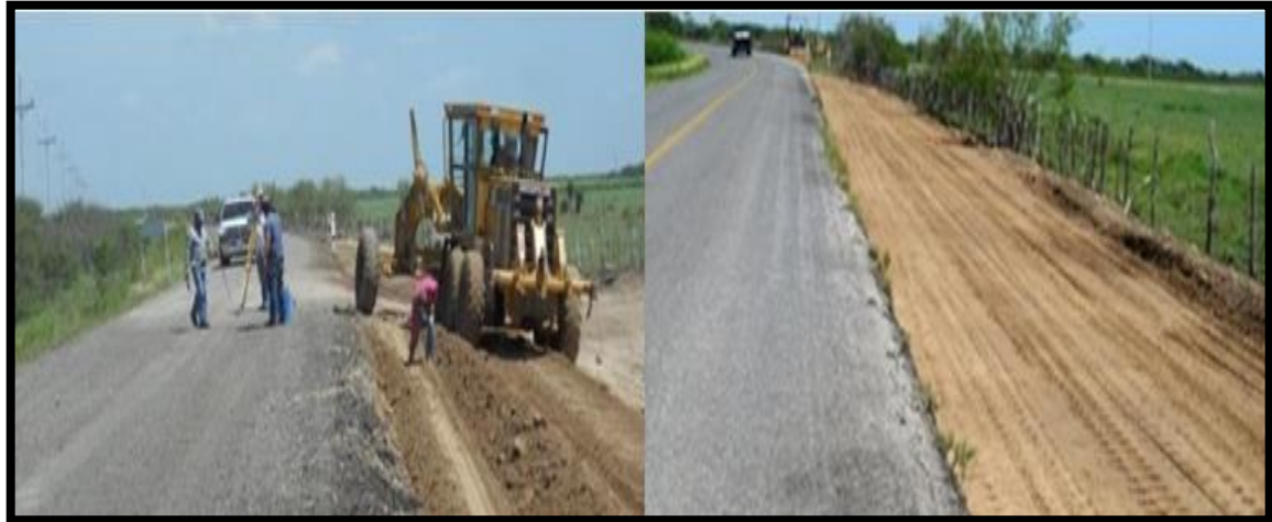
Figura 7 Servicio de ampliación de carreteras
