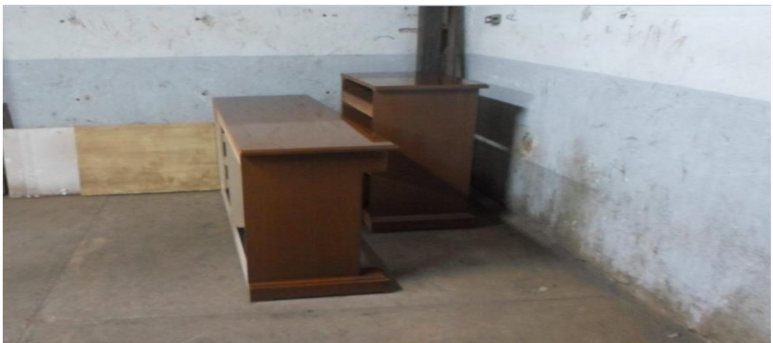
Imagen 23 Paredes de la bodega de producto terminado
