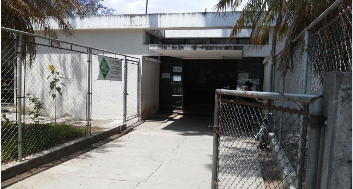
Vista de la entrada principal del Centro de Salud de Antigua Guatemala
