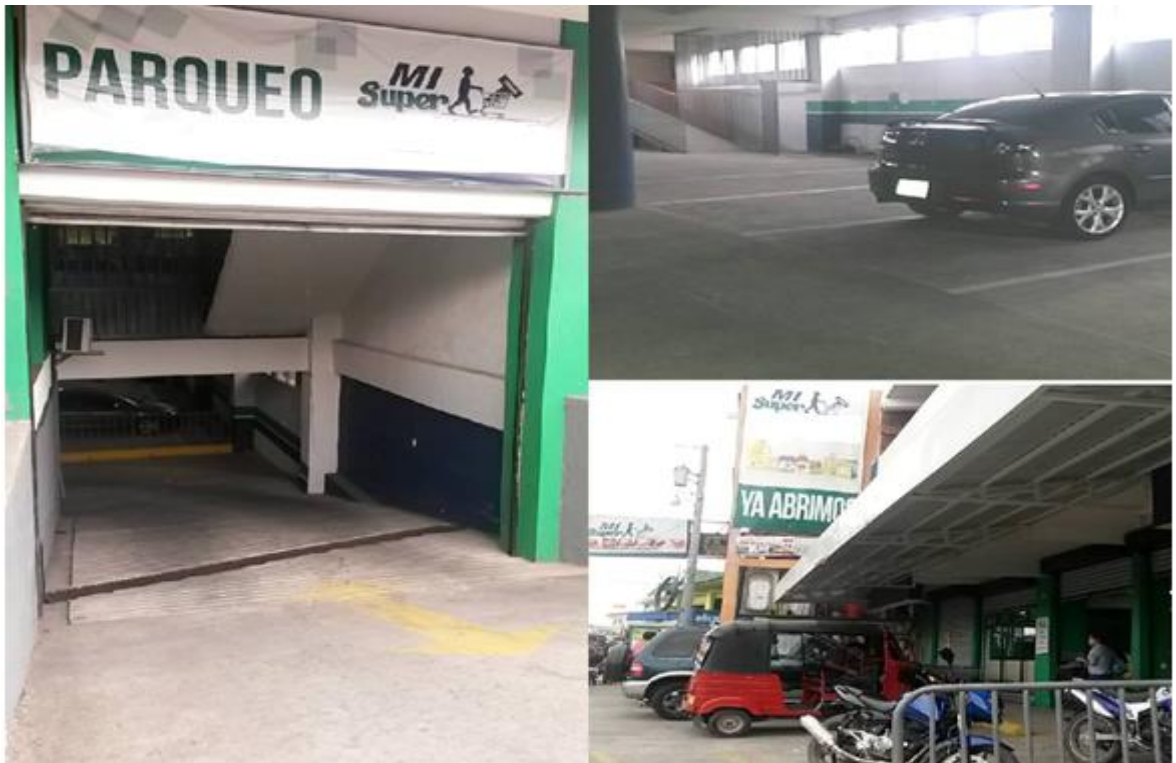
Figura 23 Parqueo del supermercado
