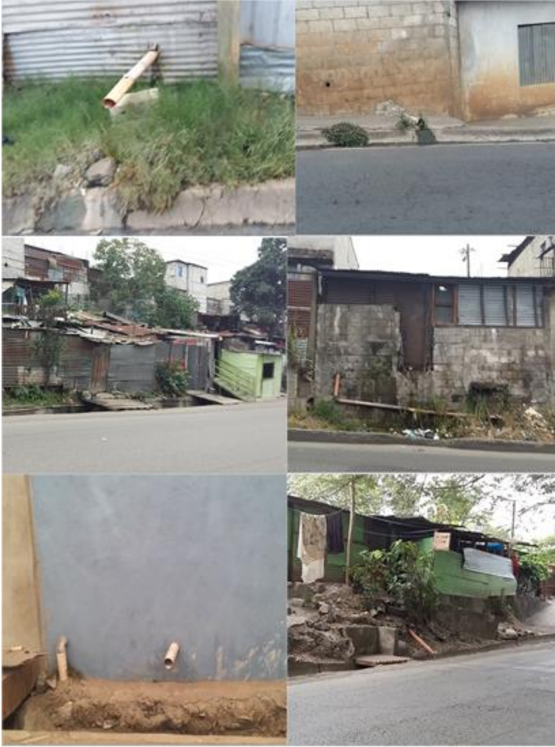
Figura 7 Sistemas de desagüe inadecuados En distintas áreas residenciales de la Cuenca del Lago de Amatitlán
