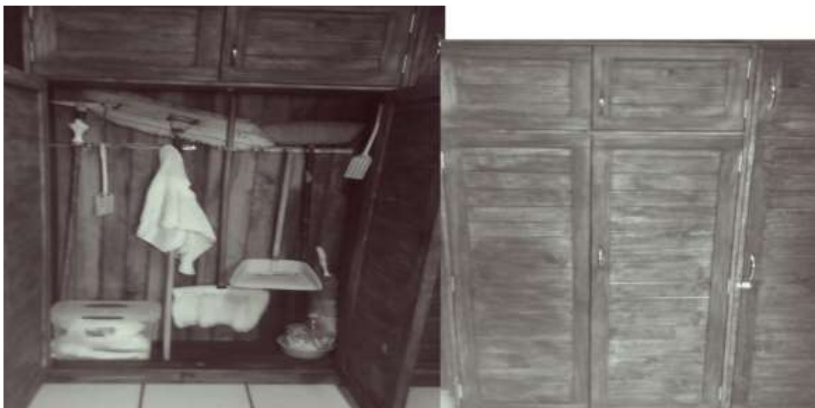
Imagen 44 Armario para útiles de limpieza
