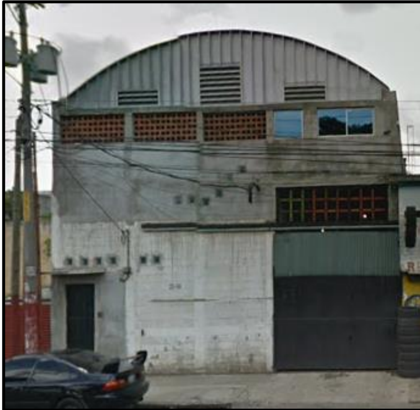
Imagen 8 Fachada de la empresa
