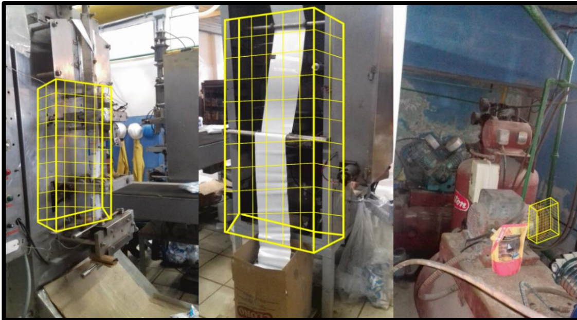
Imagen 54 Máquinas con guardas de seguridad
