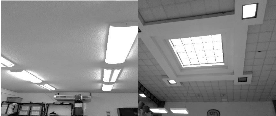
Imagen 19 Techo del primer nivel
