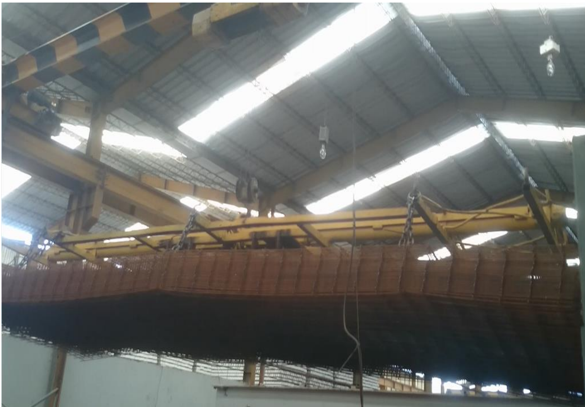
Imagen 7 Techo de la fábrica
