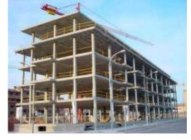
deberá cimentar el proyecto, de acuerdo a las cargas que se transmitirán al suelo; el segundo estudio es el diseño estructural del edificio, para este proyecto en específico se solicita al Ingeniero estructural que el sistema estructural sea con marcos estructurales de concreto, es decir vigas, columnas y losas, los
