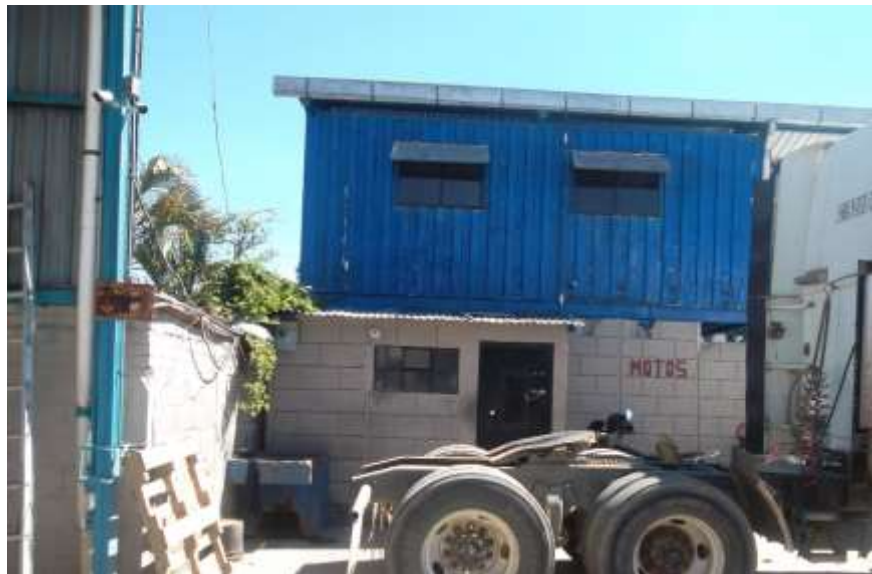
Imagen 24 Servicio sanitario área de parqueos
