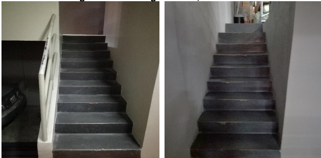
Imagen 25 Ingreso a la Bodega Central, tercer nivel
