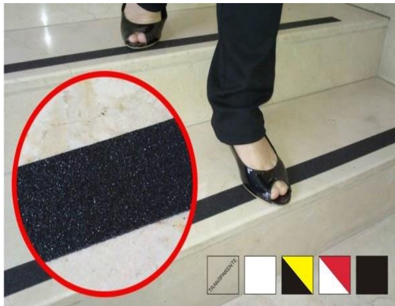
Imagen 69 Antideslizante en escaleras
