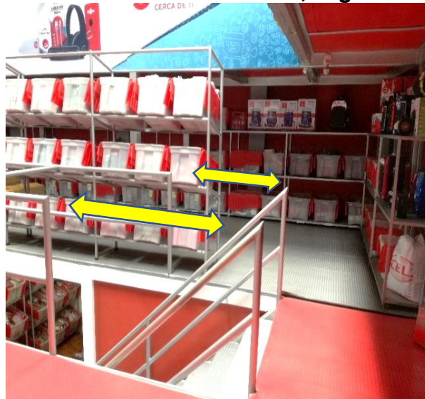
Imagen 50 Barandilla en la sala de ventas, segundo nivel
