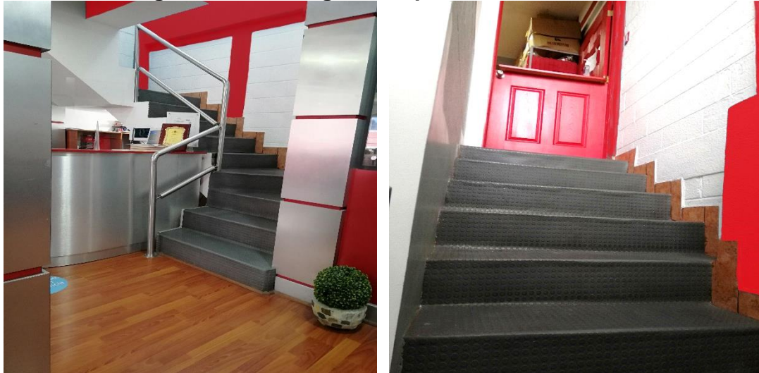
Imagen 23 Ingreso a la Bodega de Repuestos, tercer nivel
