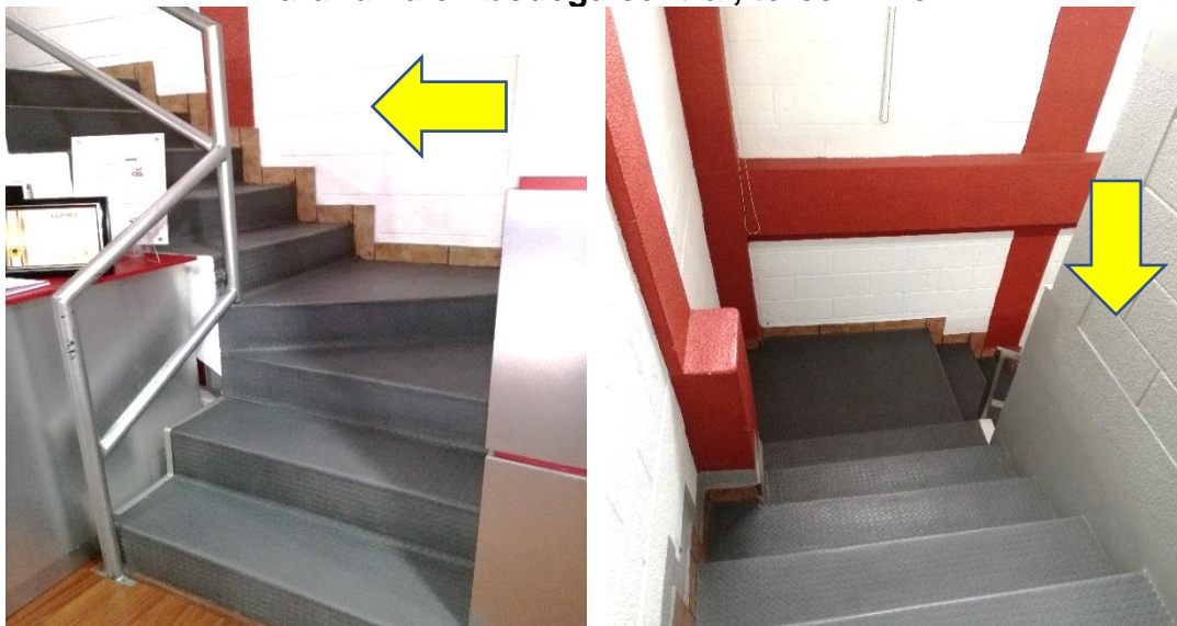
Imagen 51 Barandilla en bodega central, tercer nivel
