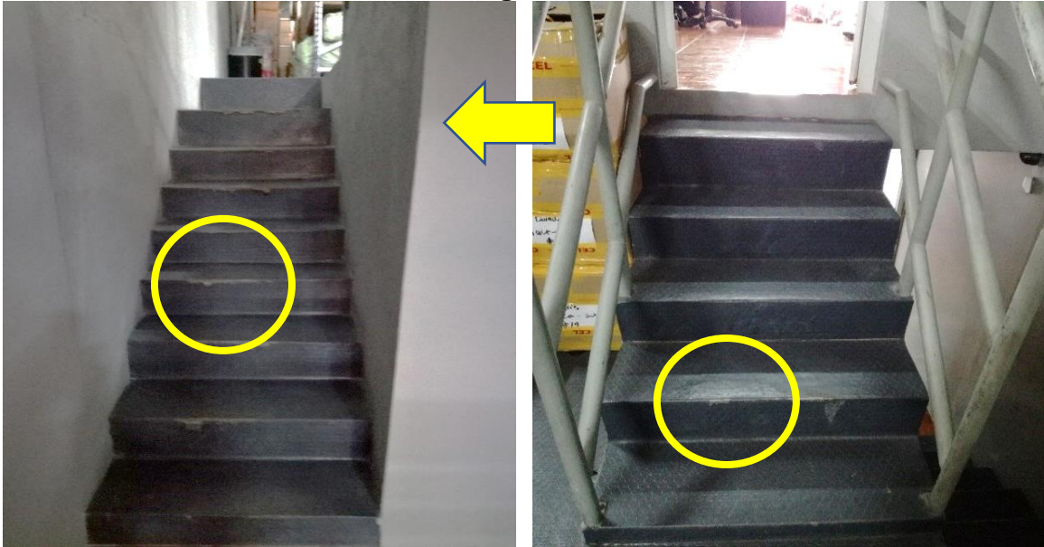
Imagen 48 Escaleras de bodega central, tercer nivel
