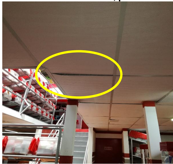
Imagen 45 Condición de cielo falso, primer nivel
