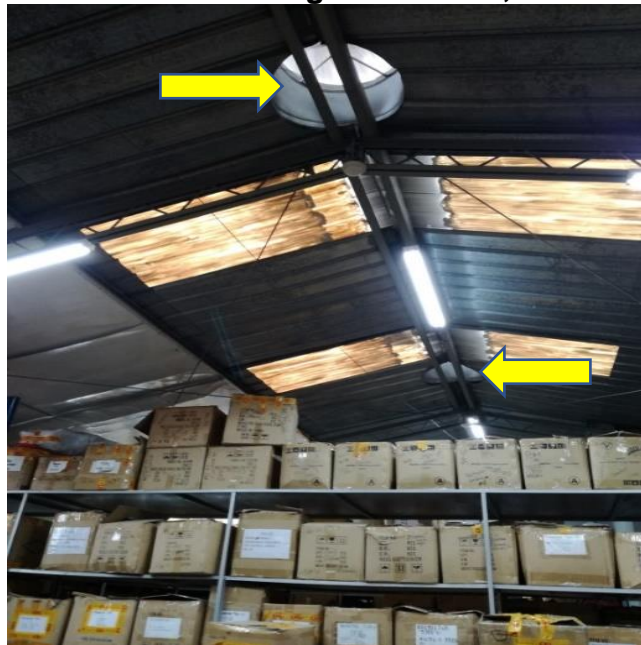
Imagen 31 Ventilación en la bodega de central, tercer nivel
