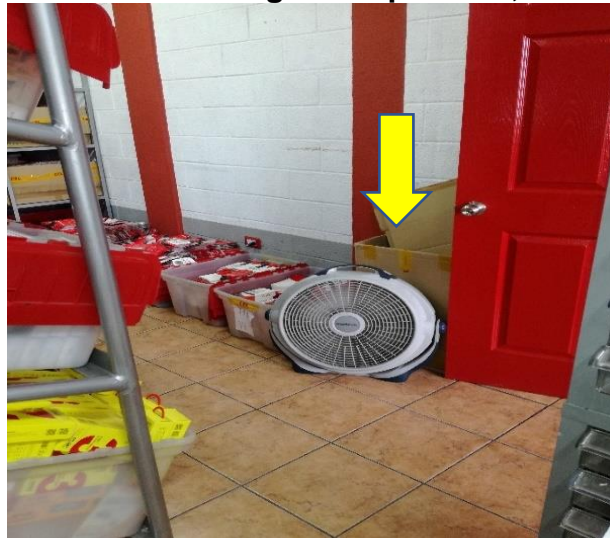
Imagen 32 Ventilación en la bodega de repuestos, tercer nivel
