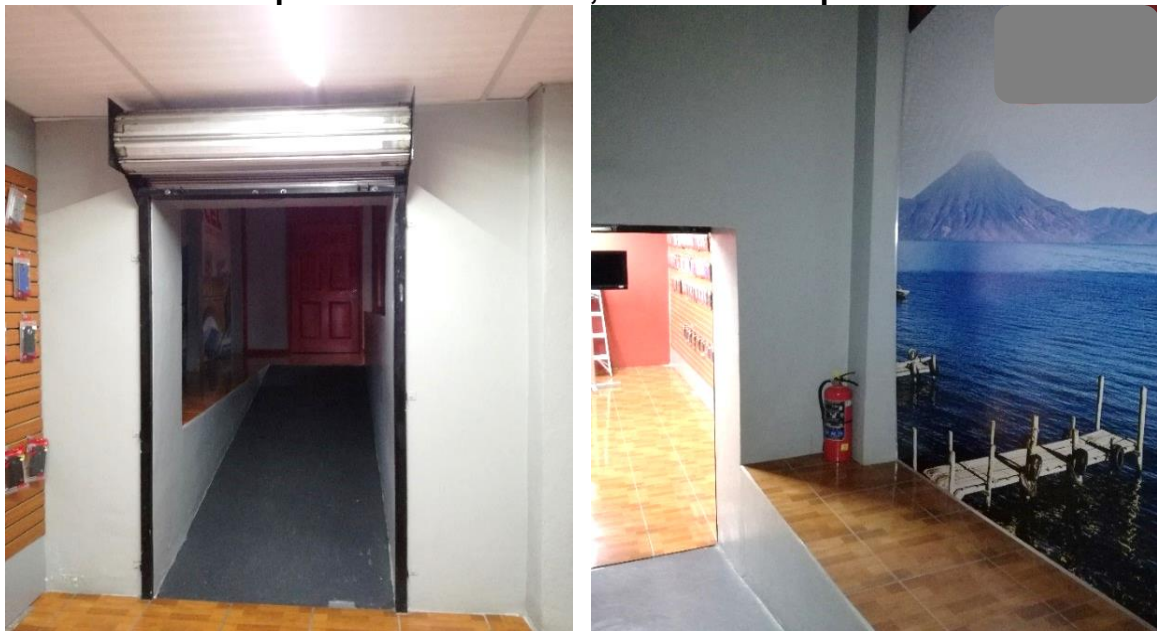
Imagen 12 Pasillo posterior del edificio, ubicado en el primer nivel
