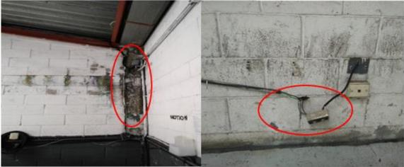
Las paredes presentan deterioro y desgaste dando un aspecto de suciedad, también se observa daño en los conectores de electricidad lo que deja expuesto el sistema eléctrico, existiendo un peligro constante debido al contacto con el agua. El jefe encargado del área indicó que por falta de autorización por parte de gerencia no se han realizado las reparaciones.
