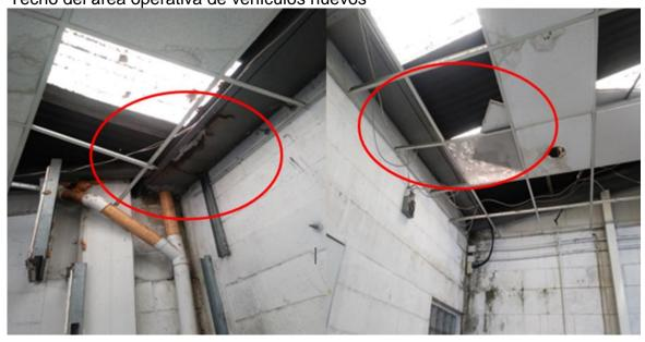
Como se puede observar en la imagen, gran parte del cielo falso del techo del área operativa de vehículos nuevos se encuentra en malas condiciones, es necesario realizar las correcciones necesarias para tener un área adecuada en la cual los colaboradores tengan la confianza que estarán seguros.
