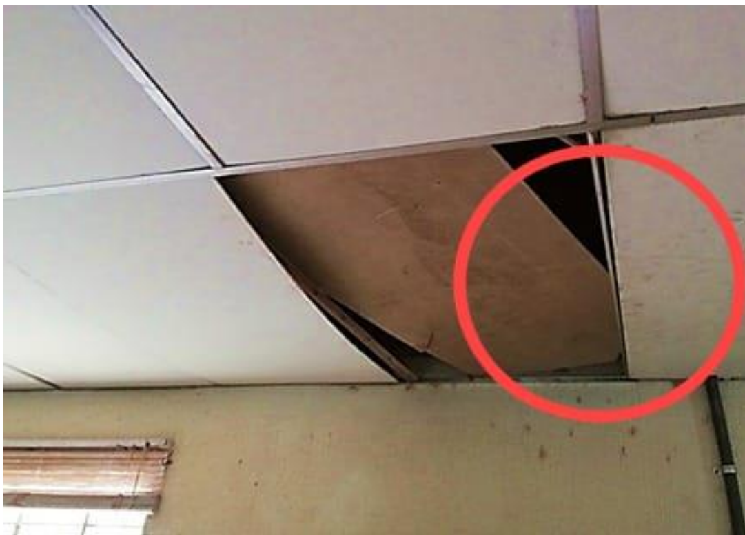
Limpieza de techos
