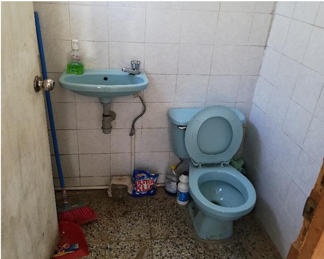
Sanitario del área operativa
