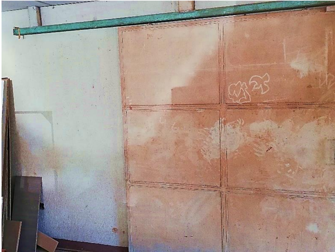
Limpieza de puertas
