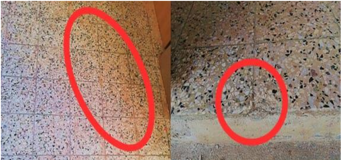
Limpieza de pisos
