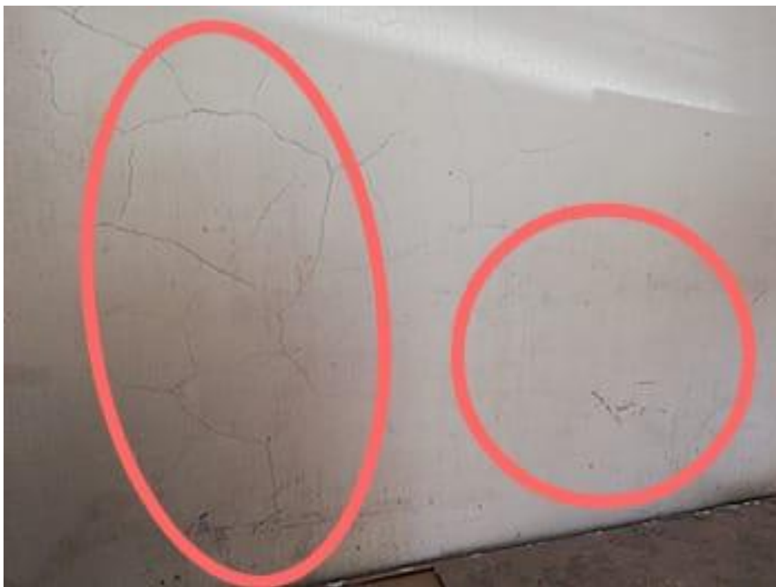
Limpieza de paredes
