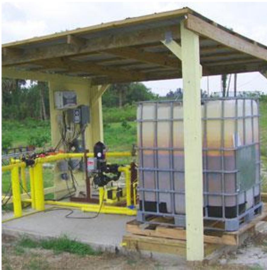
Figura 27: Ejemplo de equipo de inyección de fertilizantes similar al propuesto. Fuente: traxco.es
