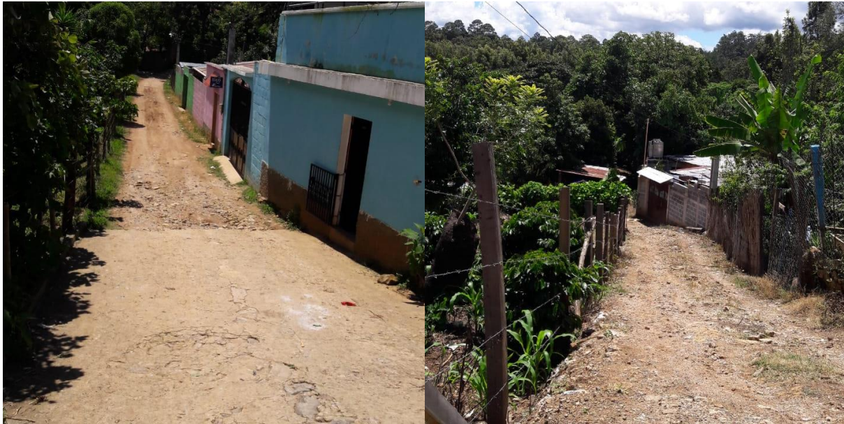
Fotografías 9 y 10: Caminos de la Comunidad sin concluir asfalto y sin asfaltar.
