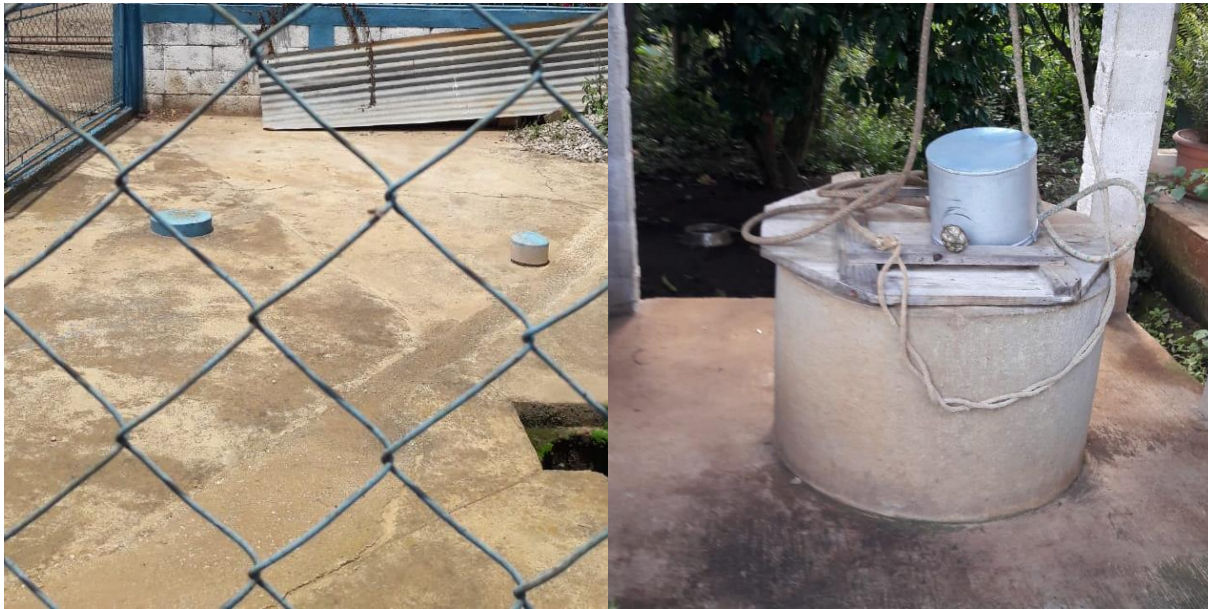
Fotografía 13 y 14: Muestra el pozo que abastece de agua a la Comunidad y por otro lado una muestra de los pozos utilizados para abastecerse en casas.
