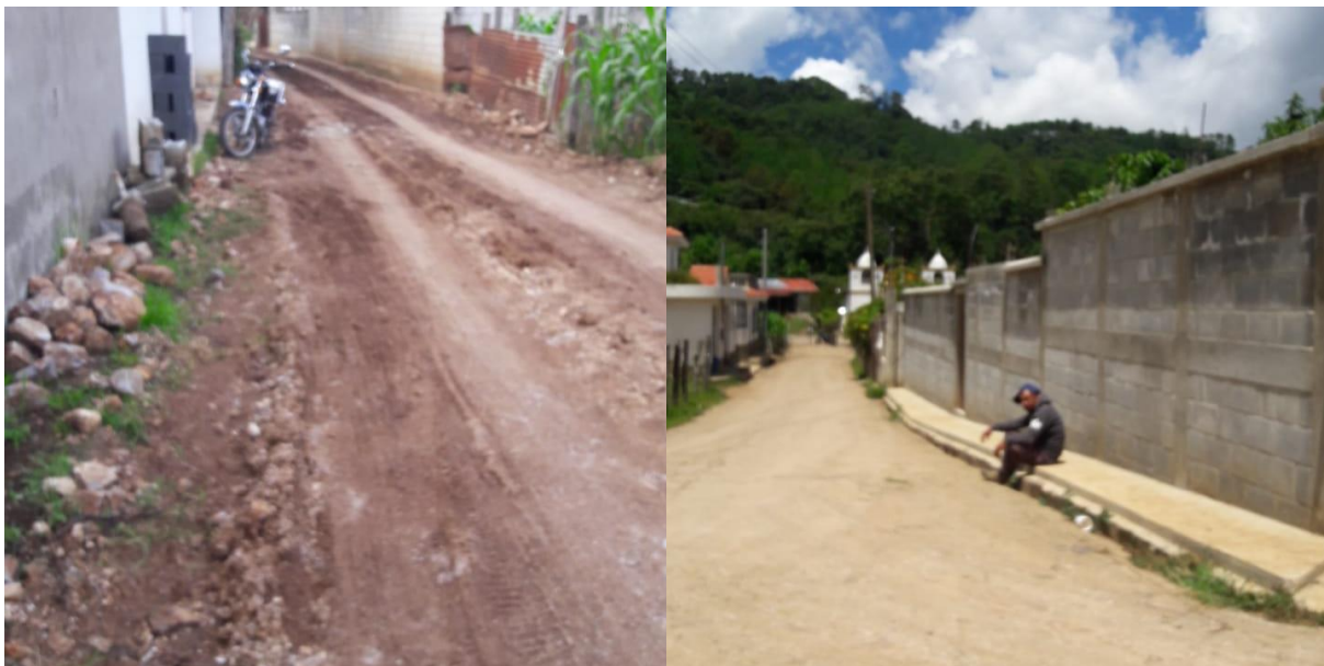
Fotografía 11 y 12: Caminos de la Comunidad iniciando trabajos de asfalto y Caminos Asfaltados.
