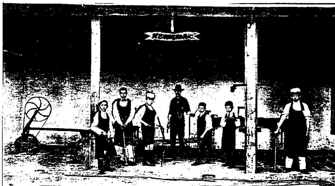
Talleres de Herrería de la Escuela Práctica de Varones "Estrada Cabrera" de la Capital. (Administración Estrada Cabrera.)
