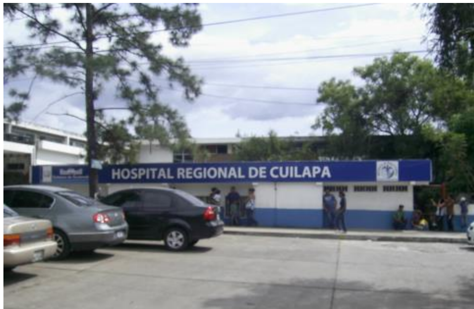
Ingreso de Emergencia
